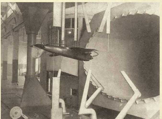
Продувка модели самолета в аэродинамической трубе Т-203
