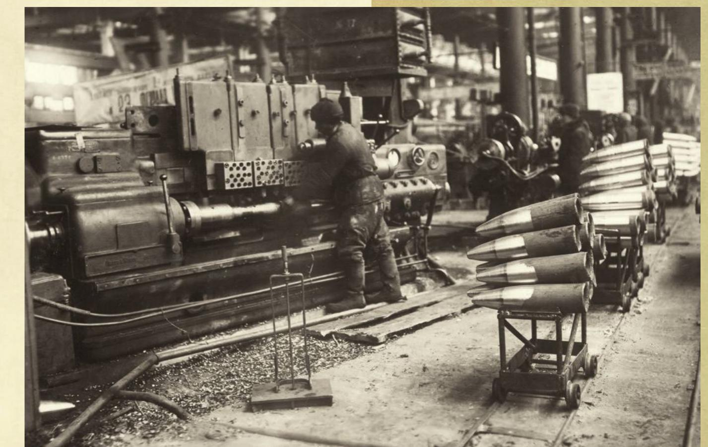
Поточное производство 45-мм осколочно-трассирующего снаряда на заводе № 65 имени Стالина.
